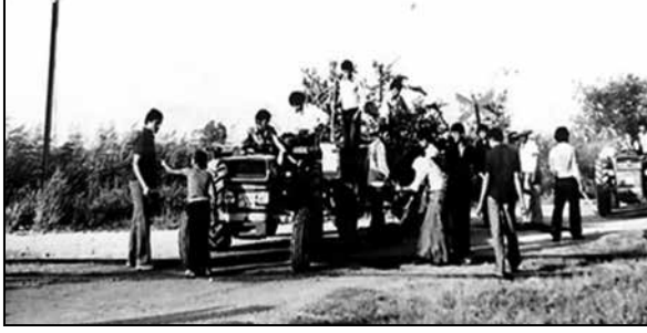
Köy yolu asfaltlama çalışması...
